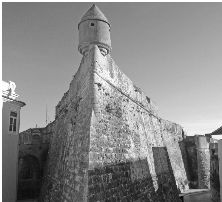
Fig 2. Forte de Nossa Senhora da Luz, Cascais.
